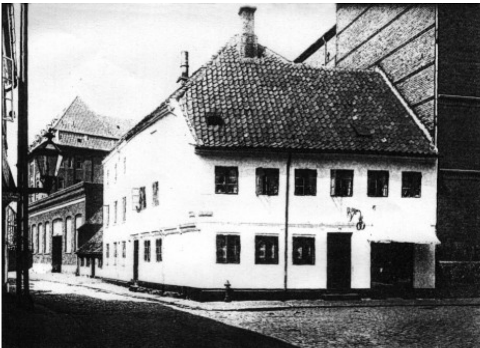
Bindingsværkshuset på hjørnet af Vestergade 66 - Vesterport I i Århus (nu nedrevet).
